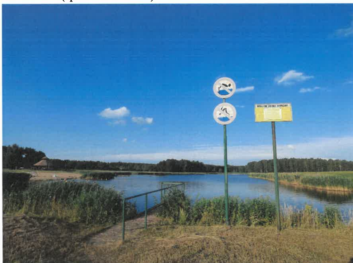
Fot. 4. Oznakowanie przy przepuście z zastawką na zbiorniku rekreacyjno-retencyjnym w Zarzeczanach, fotografia Urzędu Gminy Gródek.
