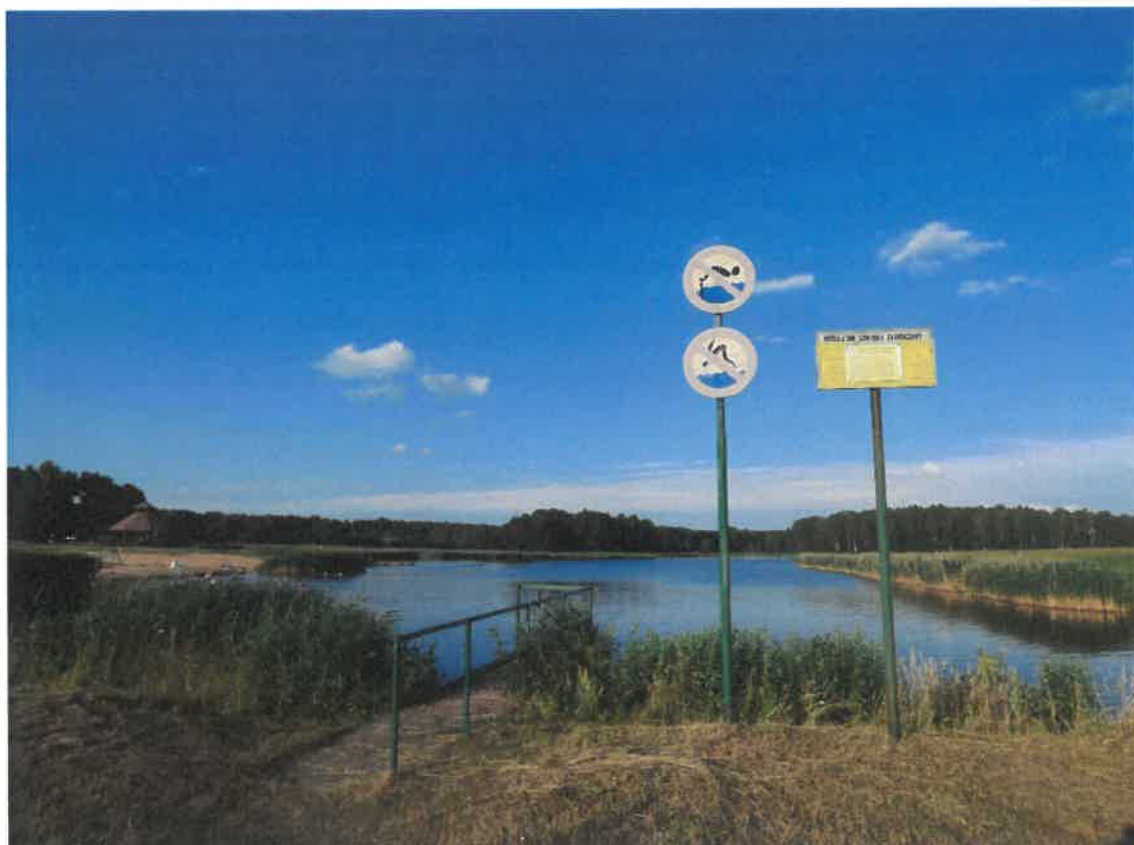
Fot. 4. Oznakowanie przy przepuście z zastawką na zbiorniku rekreacyjno-retencyjnym w Zarzecznanach
